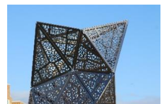
Ventilatiekokers Spaarndammer- tunnel
